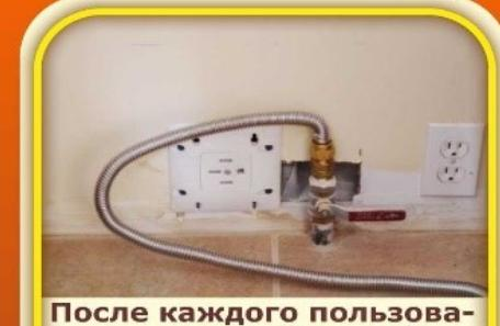
**После каждого пользования газовой плитой закрывайте краны** на плите и на вводящей трубе.
